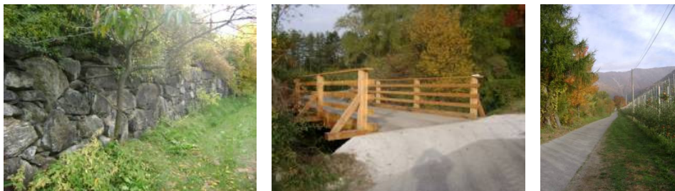
Abbildung 173. Der Uferdamm am rechten Ufer des Allitzerbachs am Mittellauf, einer der vorhandenen Stege und die Straße, entlang welcher die Murgänge orographisch links abfließen
