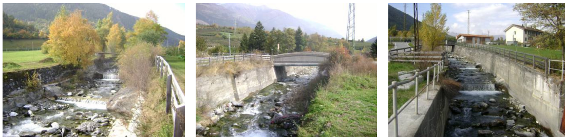
Abbildung 184. Talabschnitt des Laaserbachs, in die Projekthochwasser abfließen.
