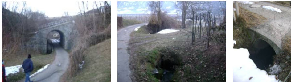
Abbildung 177. Bahnübergang und Eindolung des Tartscherbachs an der Kegelspitze und Detail eines der 177 Durchlässe im Unterlauf des Bachs.
