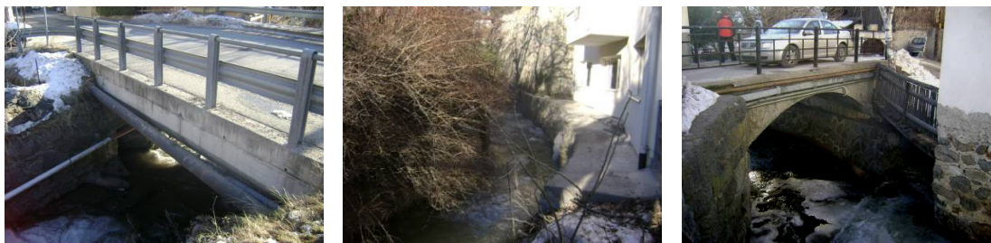
Abbildung 113. Kritische Abflussquerschnitte in der Ortschaft Mals. An der Brücke an der Landesstraße nach Burgeis (links) ereignete sich der Austritt im Jahr 1983.
