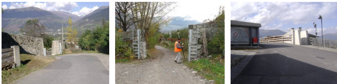
Abbildung 105. Beispiele von manuellen oder automatisierten Schiebetoren zum Schutz der Wohnungen vor Murgängen.
