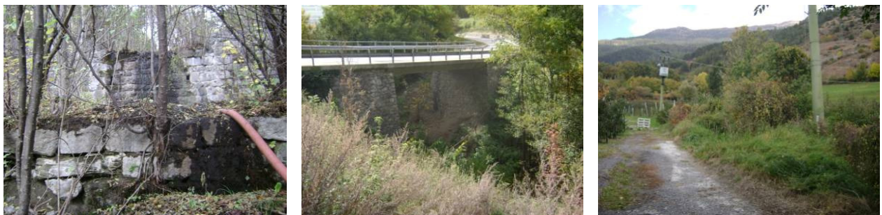
Abbildung 37. Einige Aufnahmen der vorhandenen Wasserschutzbauten am Muntaschinigbach.
