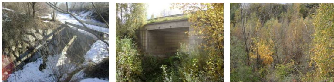
Abbildung 174. Die Künette talseitig der Sperre am Tanaserbach, die Querung der Staatsstraße und die durch die Übersarung betroffenen Flächen
