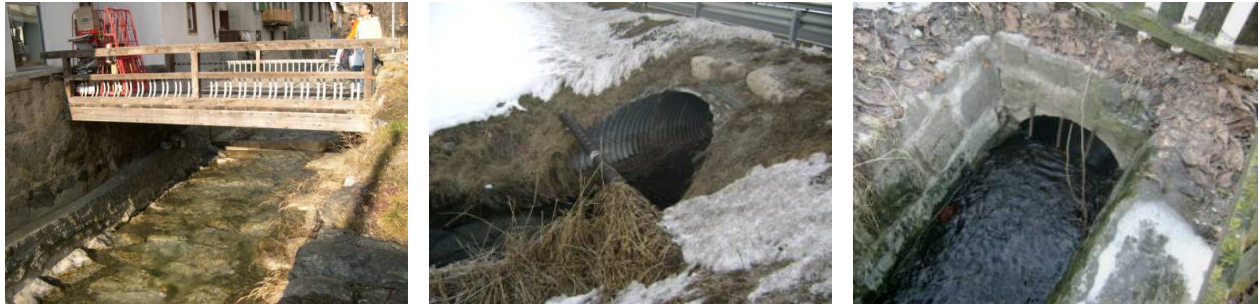
Abbildung 101. Brücken und Rohrdurchlässe stellen an Bergbächen häufig die kritischen Punkte dar.
