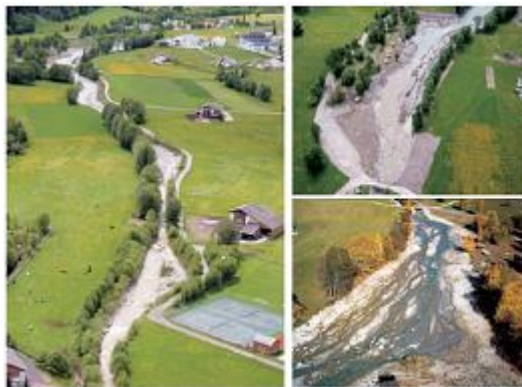
Abbildung 12. Einige Bilder der Verbauungsarbeiten am Rambach auf Schweizer Gebiet.
