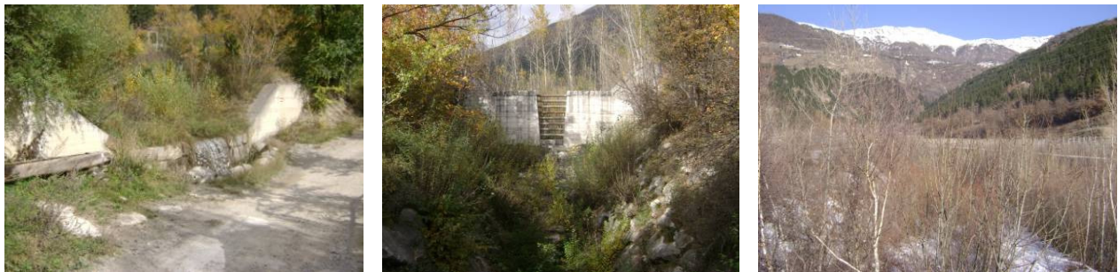
Abbildung 35. Bauten am Unterlauf, Rückhaltebecken und Filtersperre.
