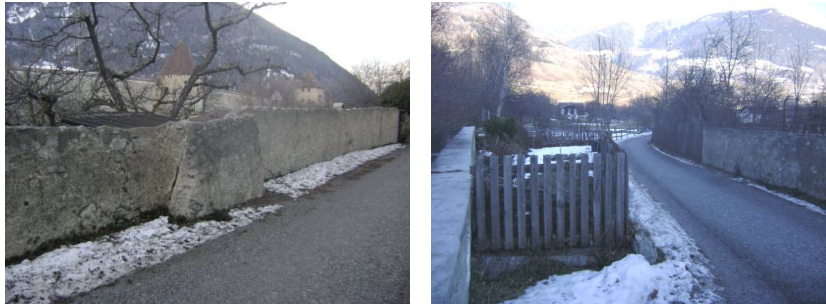
Abbildung 168. Die Schutzmauer am rechten Ufer im Verlauf des Punibachs durch Glurns.
