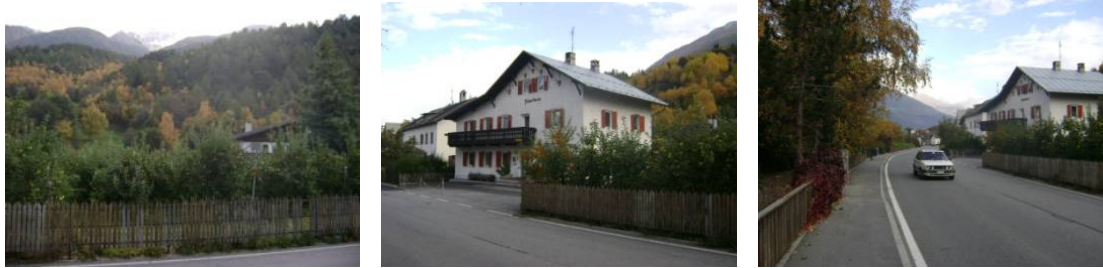
Abbildung 186. Die Areale, an denen sich die Überschwemmung des Bachs A.395.5 ausbreitet.
