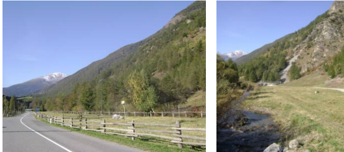
Abbildung 170. Die möglichen Überflutungsflächen am rechten und linken Ufer des Rambachs bei "Grüeb".
