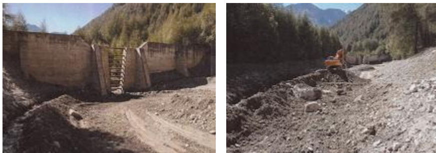
Abbildung 19. Arbeiten zur Entleerung des Rückhaltebeckens am Gadriabach im Oktober 1997.
