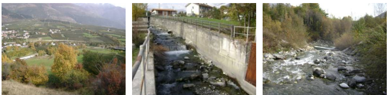
Abbildung 51. Wasserschutzbauten am Unterlauf und Panoramaansicht von Laas.
