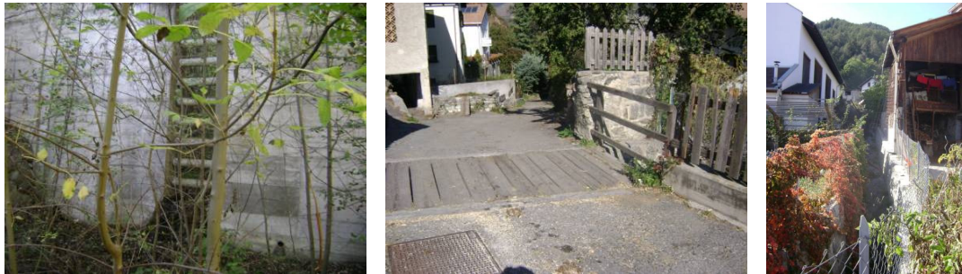
Abbildung 39. Bauten am Lichtenbergerbach.
