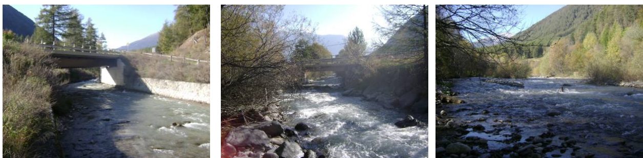
Abbildung 116. Die Kalvenbrücke und die Brücke nach Laatsch über den Rambach und die Aufweitung vor dem Untersuchungsabschnitt.
