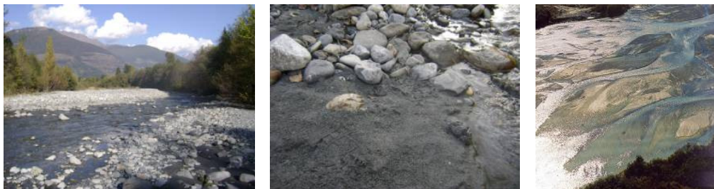
Abbildung 112. Flussaufweitung als Ablagerungsfläche bergseitig des Trapezprofils im Dorf mit Detail des abgelagerten Materials, rechts eine Aufnahme des Suldenbachdeltas in der „Prader Sand“.
