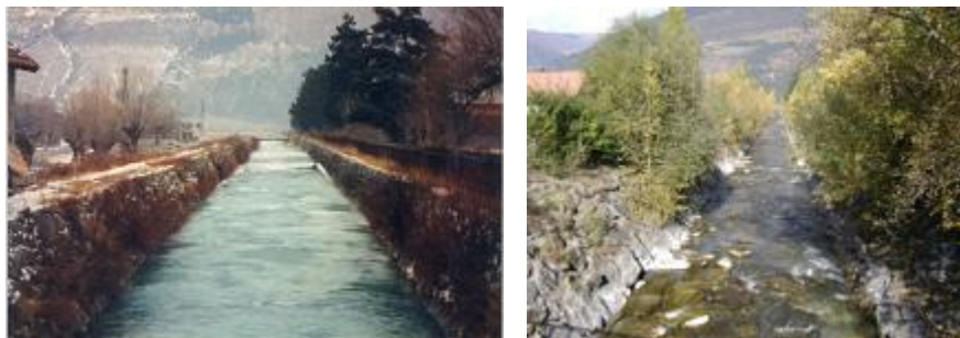
Abbildung 14. Vergleich zwischen alter und neuer Künette im Endabschnitt des Suldenbaches.
