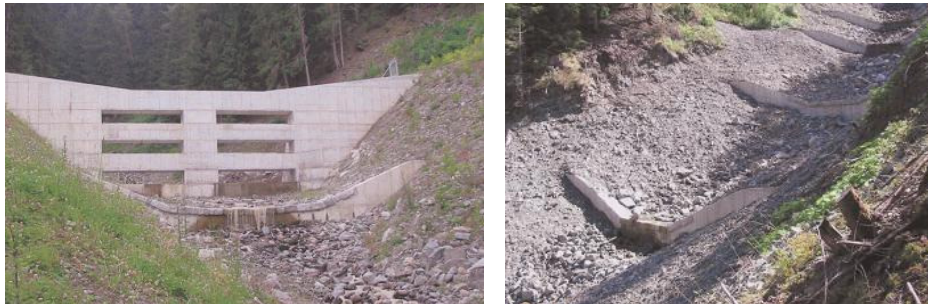
Abbildung 46. Die große Rückhaltesperre und die Konsolidierungssperren am Mittellauf des Zirnbaches.
