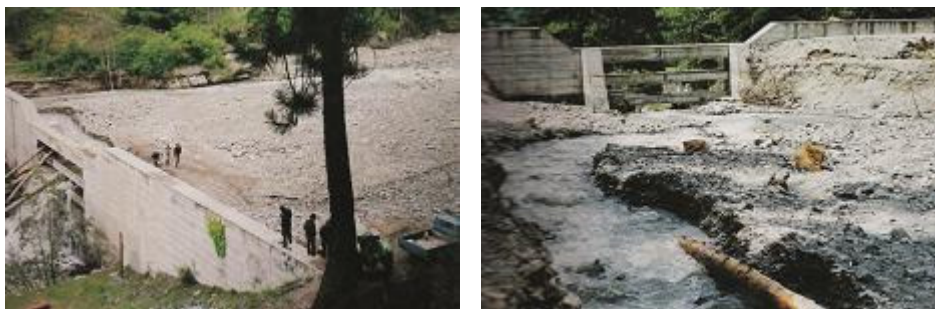
Abbildung 15. Die große Rückhaltesperre am Saldurbach nach den Ereignissen des Jahres 1983.
