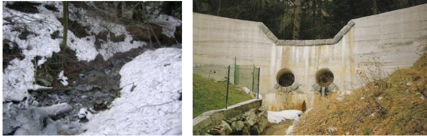
Abbildung 126. Aktives Bett des Rennergrabens und die Rückhaltesperre.
