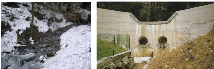
Figura 126. L'alveo attivo del rio Renner e la briglia di trattenuta.
