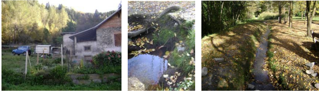
Figura 44. Il tratto terminale del torrente Schmelz.
