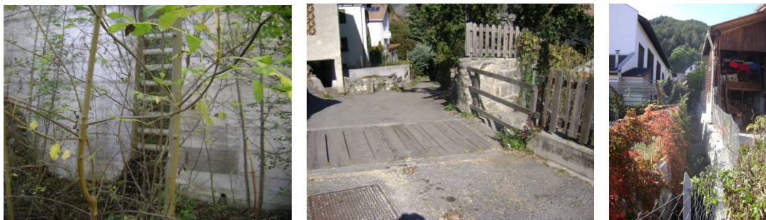
Figura 39. Sistemazioni lungo il rio Montechiaro.
