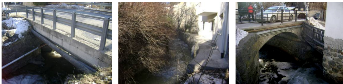
Figura 113. Sezioni di deflusso critiche nel centro abitato di Malles Venosta. In corrispondenza del ponte lungo la Provinciale per Burgusio (a sinistra) si è verificata l'esondazione nel 1983.
