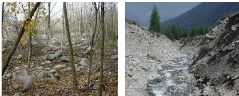
Figura 26. Depositi delle colate del 1999 nell'Ontaneto di Cengles e l'alveo del torrente scavato dalle colate.
