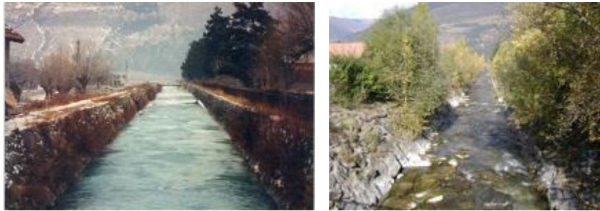
Figura 14. Confronto tra la vecchia e la nuova cunetta nel tratto terminale del rio Solda.
