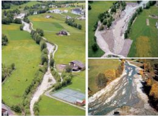
Figura 12. Alcune immagini delle sistemazioni effettuate in territorio svizzero sul rio Ram.
