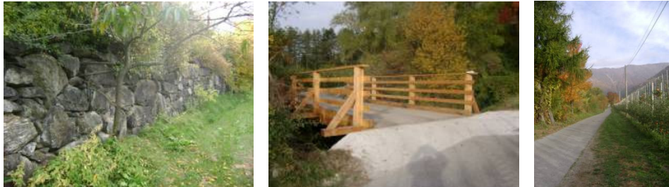
Figura 172. Il muro d'argine in destra orografica nel tratto medio del rio Allitz, una delle passarelle presenti e la strada lungo cui si incanalano i flussi in sinistra orografica.
