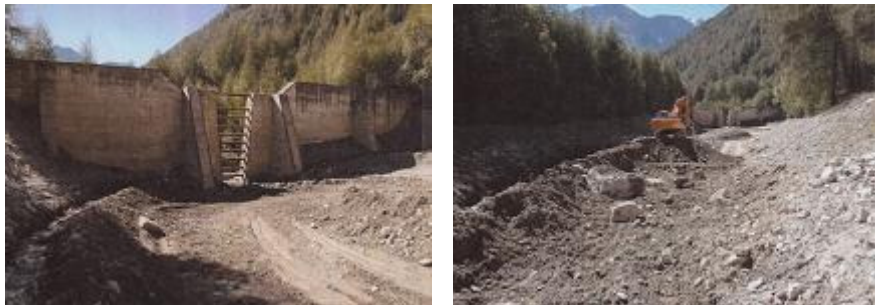
Figura 19. Le operazioni di svuotamento del bacino di ritenuto sul Gatria nell'ottobre 1997.
