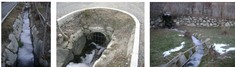
Figura 175. L'attuale alveo del rio di Cinigo e l'area in cui si verifica la biforcazione sopra descritta.
