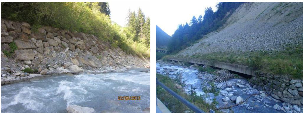
Abbildung 3. Längsbauwerke am Trafoierbach.
