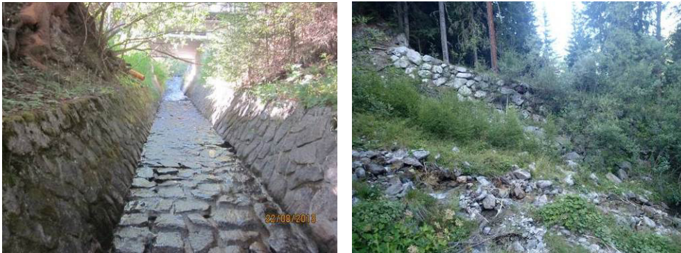
Abbildung 5. Die Kunette am Ende des Furkelbaches und rechts der Schutzdamm in orografischen Linke.
