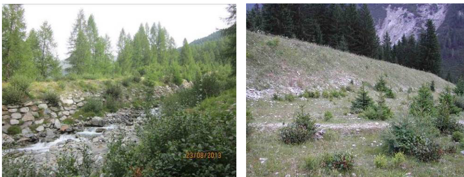
Abbildung 4. Schutzdämme gegen Vermurungen am Rosimbach (links) und Tartscherbach (rechts).
