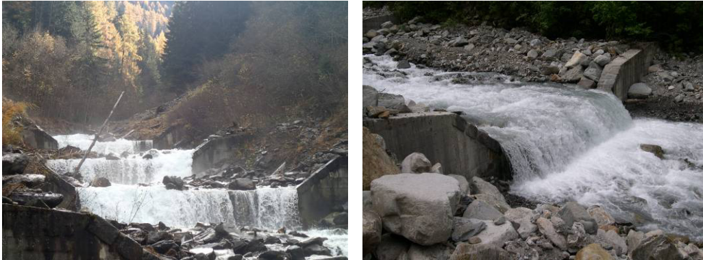
Abbildung 2. Querbauwerke am Suldenbach.
