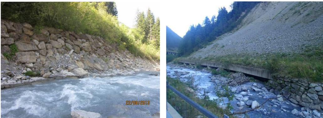
Figura 3. Opere di sistemazione longitudinali lungo il rio Trafoi.
