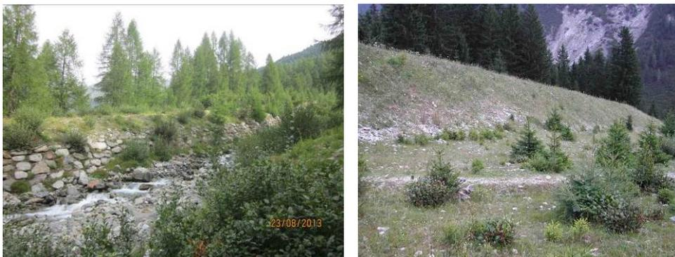
Figura 4. Argini di protezione dalle colate sui rii Rosim (a sinistra) e Tarres (a destra).
