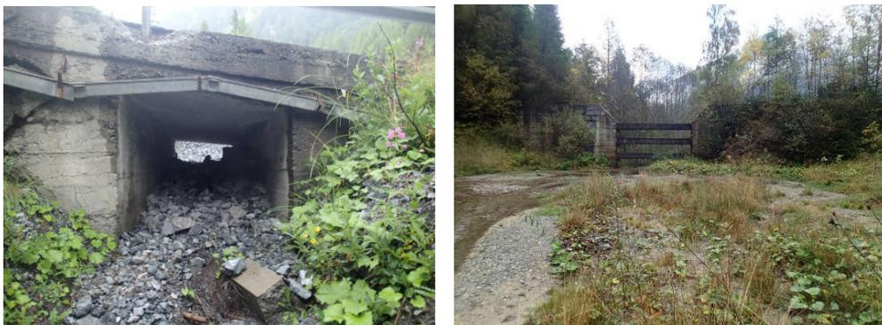
Figura 6. L'attraversamento stradale lungo il rio Marlet e, a destra, il bacino di deposito sul rio di Valle di Plaz.
